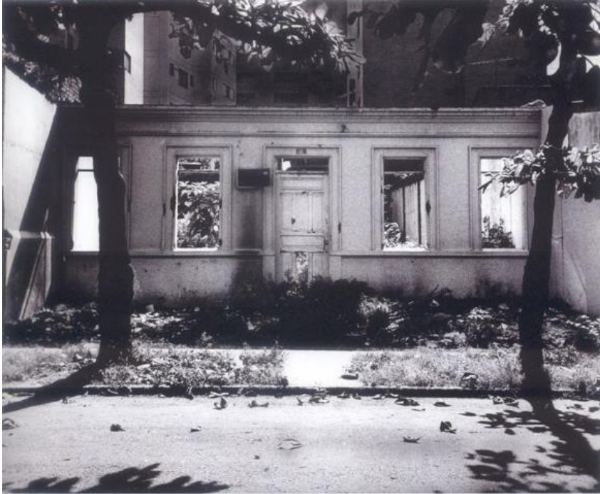
Imagen 7. Fotografía de una pared en proceso de demolición de Cali Fuente: Fotografía tomada por Fernell Franco. Serie Demoliciones, Cali 1990-1995, http://fernellfranco.org/galeria.html
