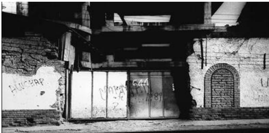
Imagen 6. Demoliciones en la Ciudad de Cali 1990-1995
